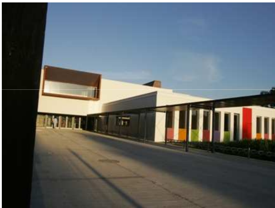
Construction collège Lucie Aubrac de Vertou (2007)
