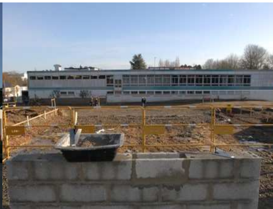
Rénovation collège Stendhal de Nantes (en cours)
